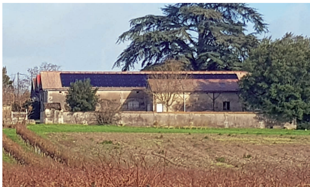
Sainte-Lheurine : panneaux installés sur un bâtiment communal dont la toiture a été mise à disposition de la SEM EMA (2019).
