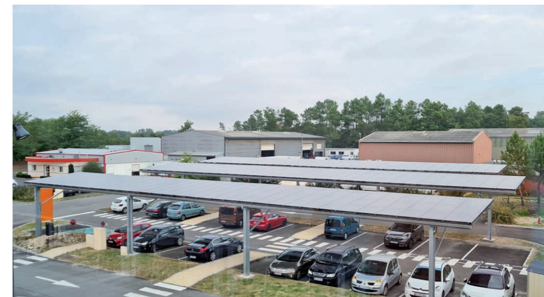
Saint-Aubin-de-Blaye [33] : ombrières installées sur un parking mis à disposition de la SEM EMA par la CDC de l'Estuaire (2020).
