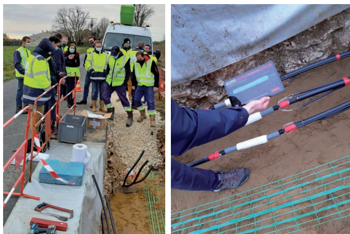
Réalisation de la « boîte de jonction » souterraine sur les trois phases de câbles 20 000 volts, sous « l'œil » vigilant de l'application développée par Nexans.
