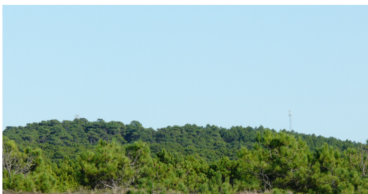
La nouvelle antenne-relais (à droite sur la photo), près de l'ancien amer du Gardour que l'on distingue à gauche.
