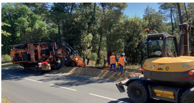
L'entreprise attributaire des travaux de l'opération d'extension à l'œuvre : pose en souterrain sur l'accotement, à la tranchée.
