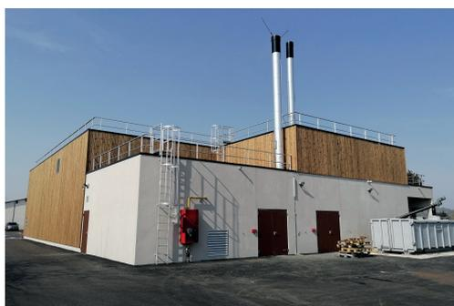
La chaudière biomasse de 1 000 kW est alimentée à plus de 90% par la combustion de bois, provenant d'un rayon de 100 km maximum. Sa consommation est de 1 000 tonnes de bois par an (ce qui
