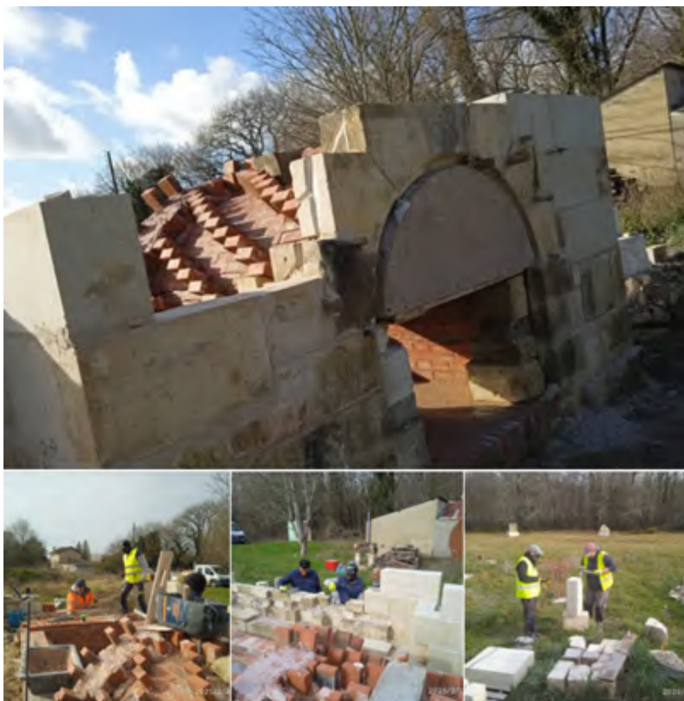
Construction du four à chaux à Thénac par les salariés en insertion de l'association Le Sas.
