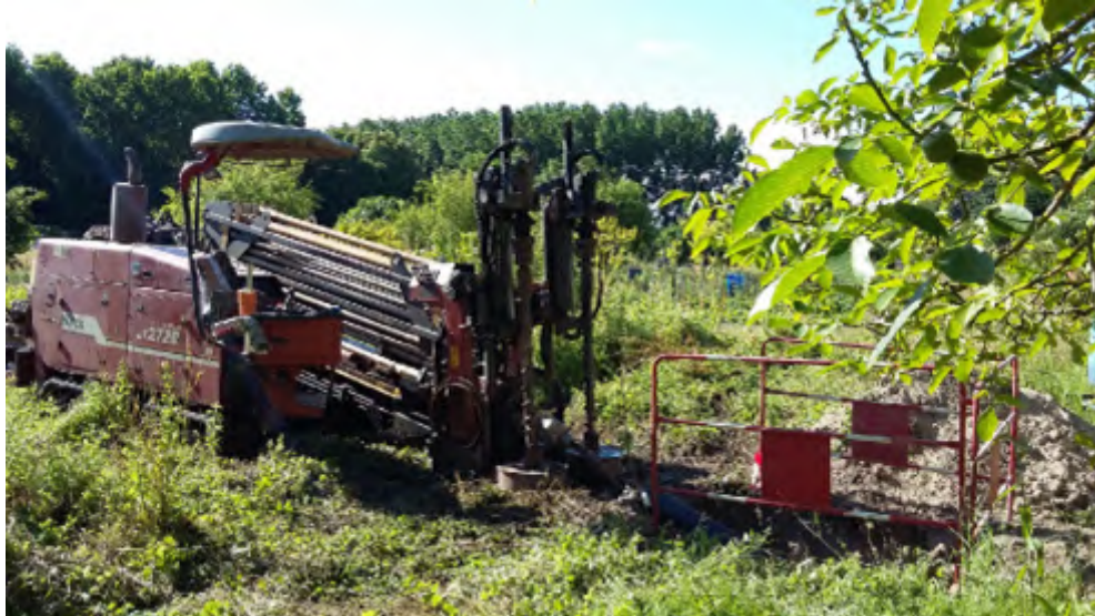
Utilisation du forage dirigé pour passer sous des voiries sans terrasser en traversée de route lors de travaux de renouvellement ou création en souterrain de ligne électrique 15 000 volts ou 20 000 volts.
